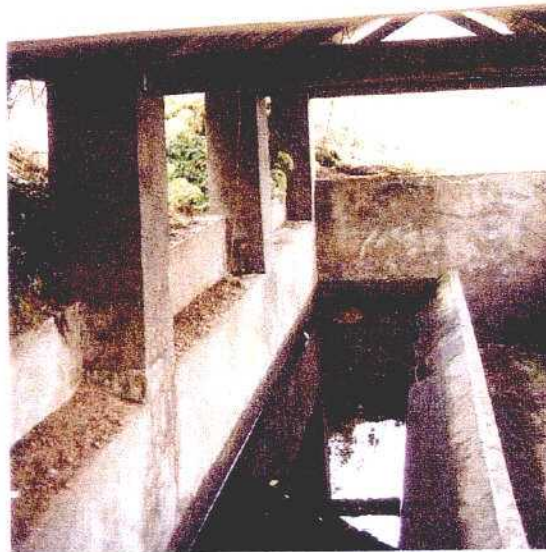
Detalle del lavadero
